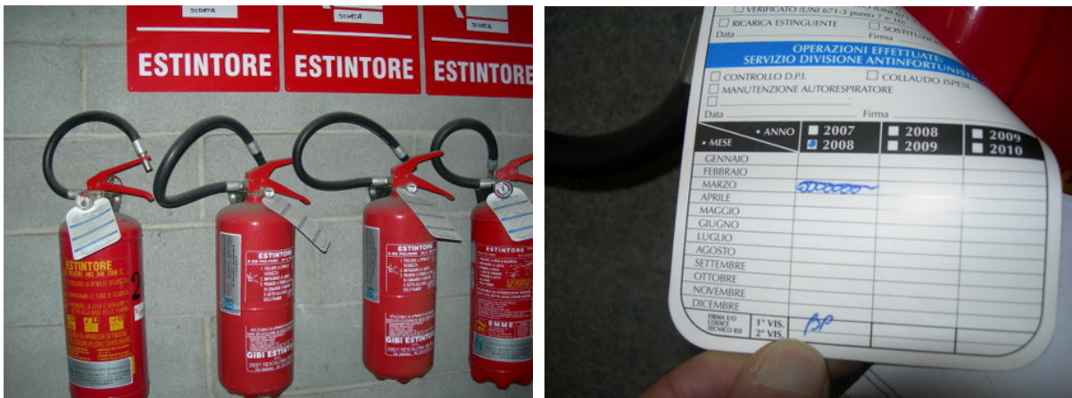
Fig. 4.4: Verifica periodica estintori.
