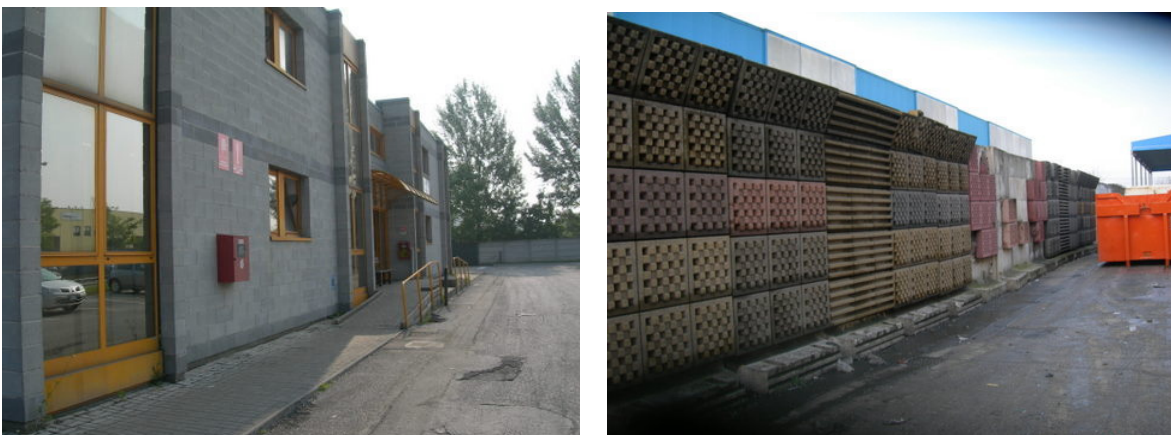
Fig. 4.3: Piazzali esterni all'impianto.
