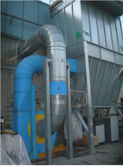
Fig. 6.1: Sistema trattamento aria e camino di emissione.
