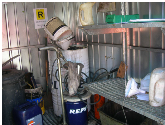
FIG. 5.6: Sistemazione del deposito oli – il ricovero è sistemato in luogo isolato, il pavimento in grigliato consente il drenaggio di spanti senza formazione di zone di ristagno, la cartellonistica è presente, sono disponibili le schede di sicurezza dei materiali manipolati.
