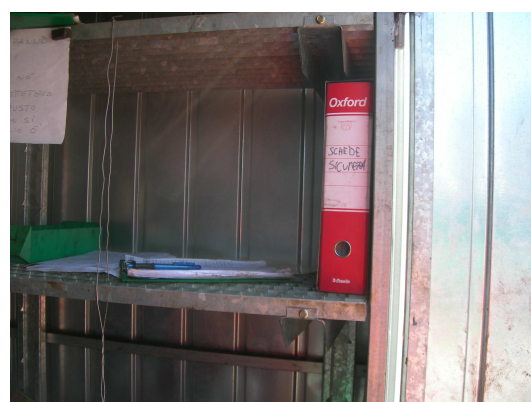
FIG. 5.6: Sistemazione del deposito oli – il ricovero è sistemato in luogo isolato, il pavimento in grigliato consente il drenaggio di spanti senza formazione di zone di ristagno, la cartellonistica è presente, sono disponibili le schede di sicurezza dei materiali manipolati.
