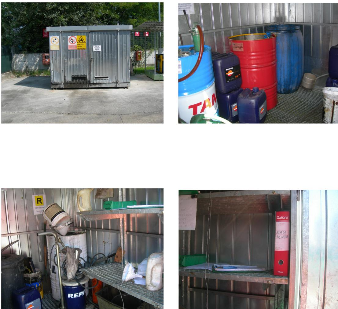
**FIG. 5.3: Sistemazione del deposito oli** – il ricovero è sistemato in luogo isolato, il pavimento in grigliato consente il drenaggio di spanti senza formazione di zone di ristagno, la cartellonistica è presente, sono disponibili le schede di sicurezza dei materiali manipolati.
