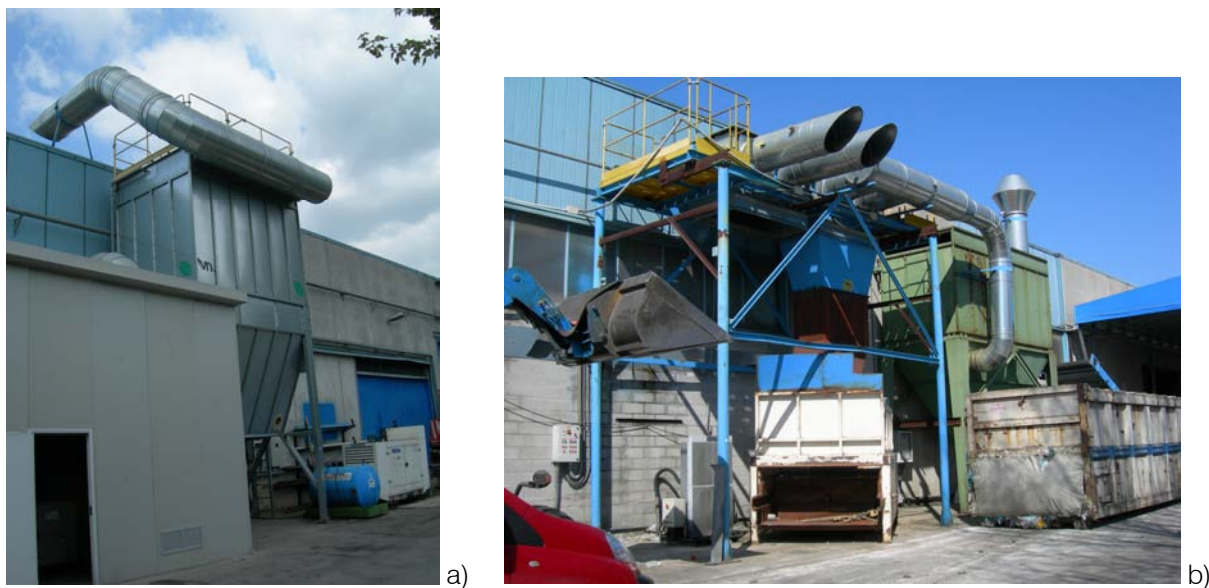
Fig. 6.1: Sistemi trattamento aria e camini di emissione: a) camino 1 b) camino 2
