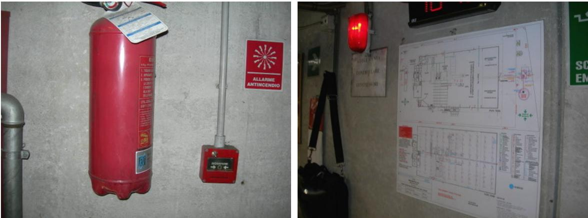
Fig. 4.9: Esempi di dispositivi di sicurezza e planimetrie presenti in impianto.
