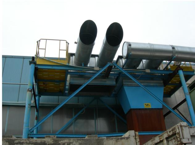
Fig. 6.2: Sistemi trattamento aria e camini di emissione.
